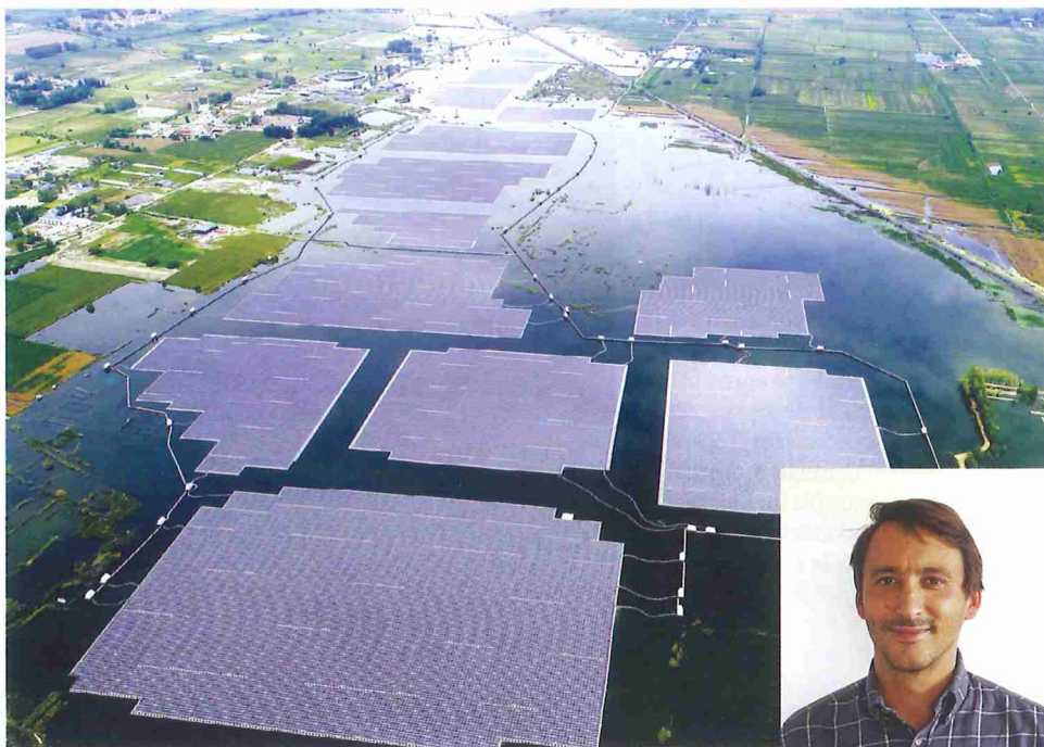
Panneaux solaires flottants. Province de Anhui, en Chine.
